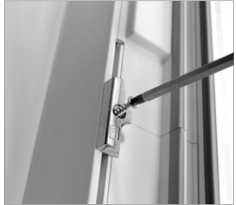
Verschrauben der Schließstücke
