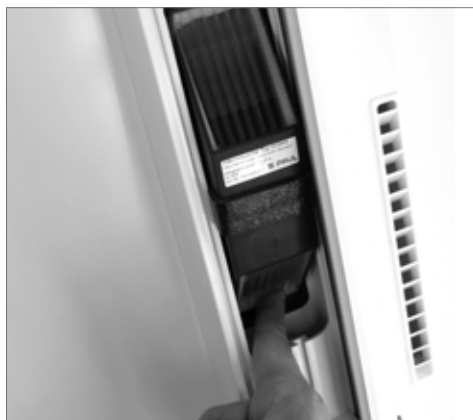
Herausziehen des Wärmetauschers
